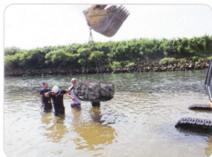
ウナギなどの生物の隠れ処を設置する様子 (大分県 大野川)
