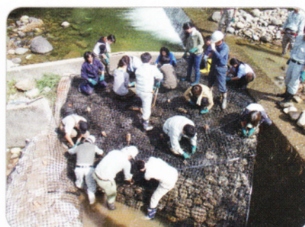
学生と協働して、魚が川を上るための 魚道を改修する様子 (富山県 富山漁協提供)
